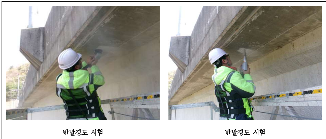
【사진 27.4.2】 반발경도시험 현장사진
