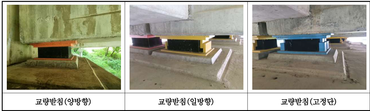
【사진 27.3.13】 교량받침 전경
