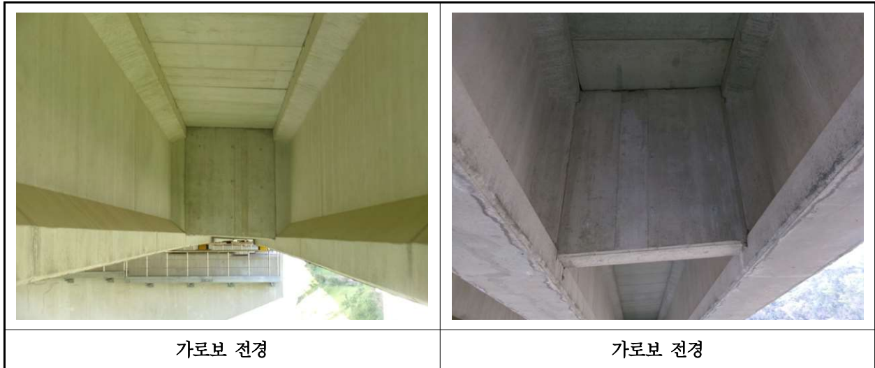
【사진 27.3.6】 가로보 전경
