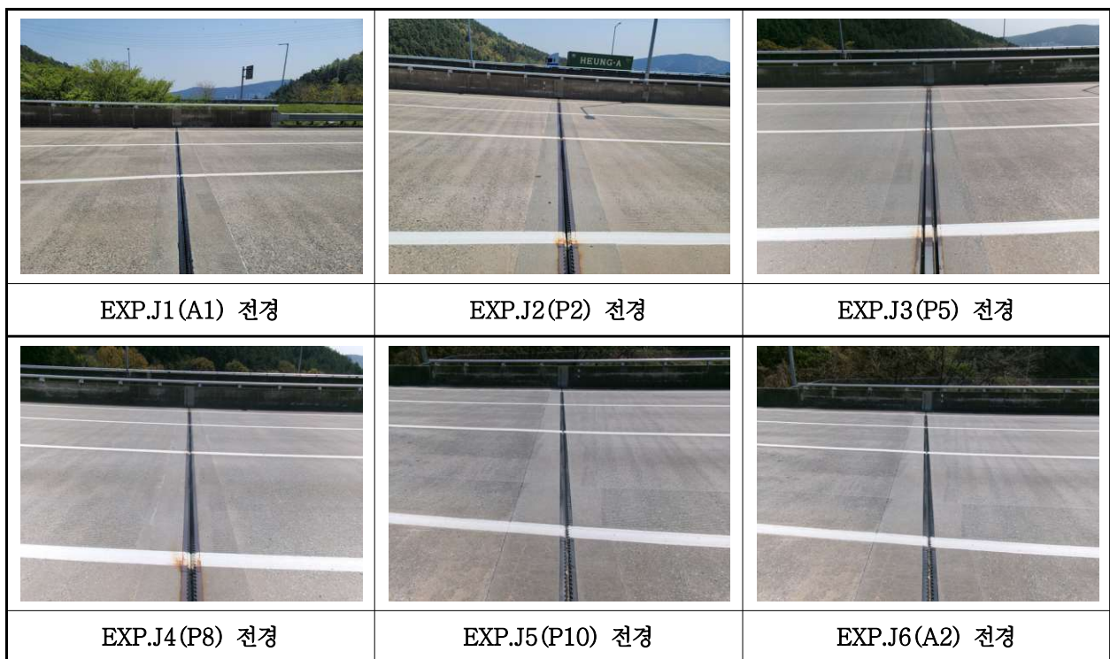
【사진 27.3.17】 신축이음장치 전경
