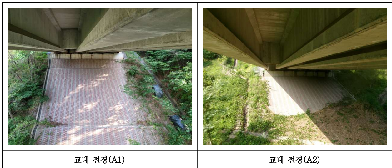
【사진 27.3.8】 교대 전경
