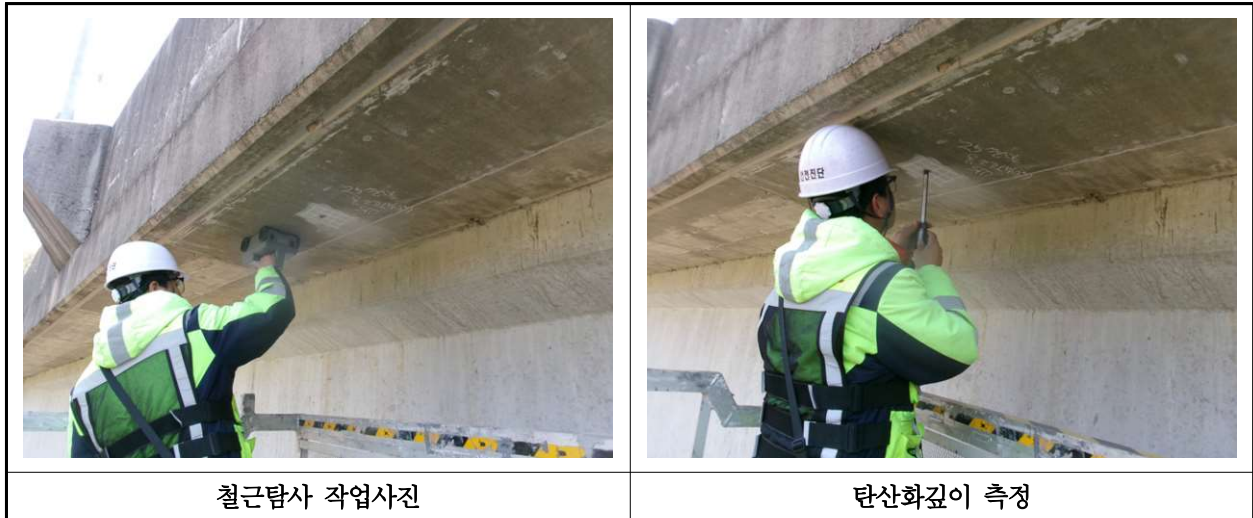
【사진 27.4.3】 탄산화 깊이 측정 현장사진
