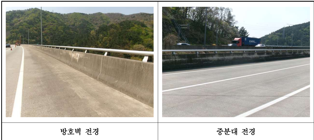
【사진 27.3.24】 방호벽 및 중분대 전경
